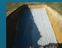
POSE DU GEOTEXTILE
