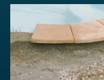
POSE DES MARGELLES
